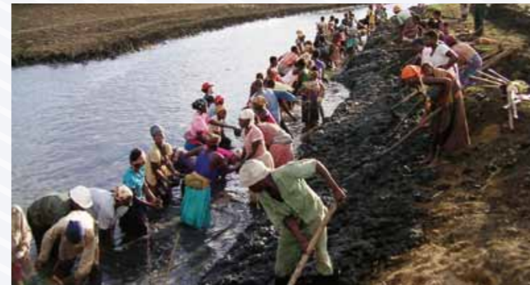
地域の人々総出でおこなった幹線水路の清掃
